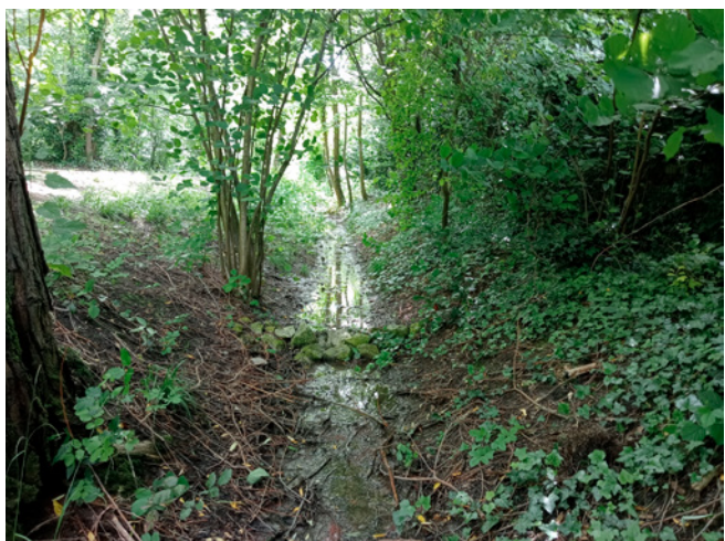
Noue de ruissellement et d'infiltration en milieu boisé, bois de l'Aurore, Antony (92). / Maxime Dépinoy, Plante & Cité
