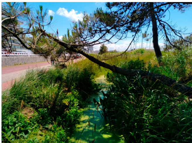
Noue aquatique en bord de mer, qui longe la plage, boulevard Albert 1 er , Le Havre (76). Elle s'apparente à une noue de ruissellement dans son fonctionnement, bien qu'elle ait été conçue pour rester en eau une grande partie de l'année, la rapprochant davantage du cours d'eau. / Maxime Dépinoy, Plante & Cité
