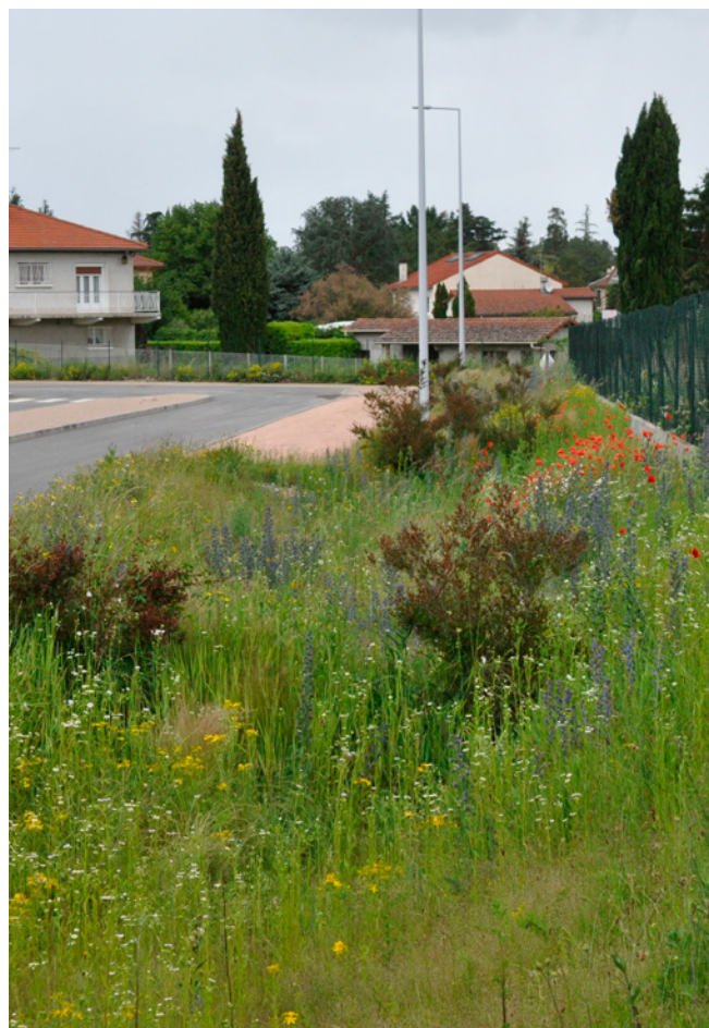
Noue d'infiltration conçue en 2018 entre un parking et un milieu prairial à Saint-Just-Saint-Rambert (42). Lors de la prise de vue en 2024, aucune opération de curage n'est programmée. L'aménagement est fonctionnel sur le plan de la gestion des eaux pluviales sans rencontrer de difficultés particulières. / Maxime Dépinoy, Plante & Cité
