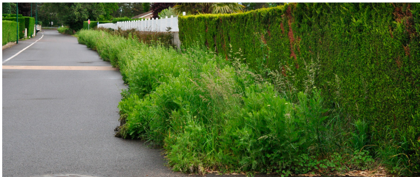
Aménagement comprenant une noue végétalisée au chemin des Lièvres, à Veauchette (42). / Maxime Dépinoy, Plante & Cité
