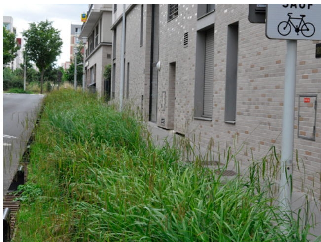
Noue d'infiltration étroite séparant la route d'un trottoir en milieu urbain dense, rue Germaine Tillion, Nanterre (92). La noue collecte les eaux de ruissellement de la voirie et des toitures environnantes, et est également associée à un bassin de rétention des eaux pluviales végétalisé. / Maxime Dépinoy, Plante & Cité
