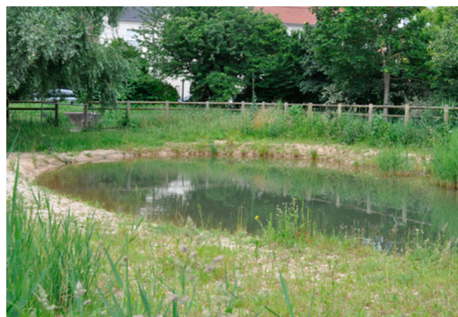
Bassin collectant les eaux provenant d'une noue de transfert au parc des Chênevieux, à Nanterre (92). / Maxime Dépinoy, Plante & Cité
