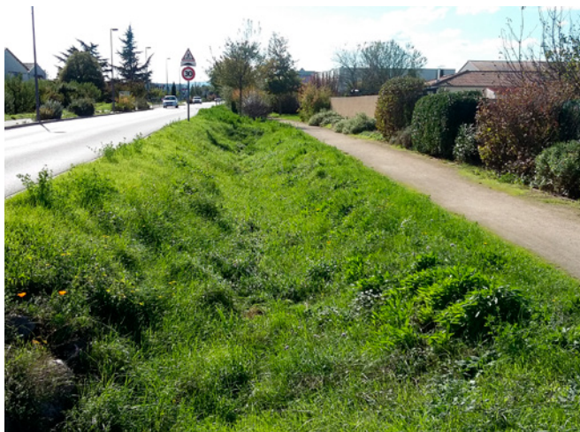
Noue herbacée en accompagnement de voirie, avenue de Provence, Saint-Marcel-lès-Valence (26). / Maxime Dépinoy, Plante & Cité
