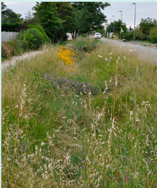
Noue soumise à un climat chaud en plein soleil qui assèche la végétation, à Saint-Marcel-lès-Valence (26). Elle fait l'objet d'une gestion semi-intensive en suivant une logique de gestion différenciée. Deux fauches sont réalisées par an, dont une fauche d'été pour améliorer son aspect esthétique. / Maxime Dépinoy, Plante & Cité
