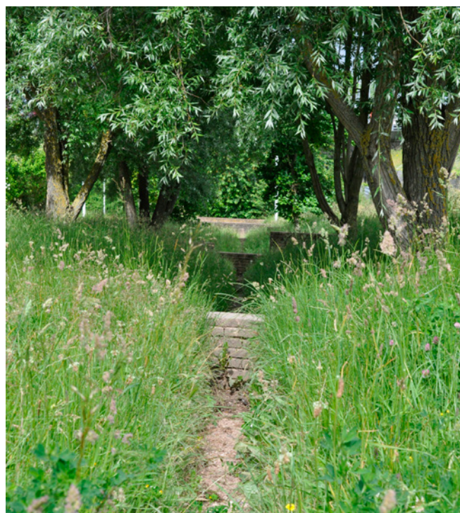
Noue présente dans le parc des Chênevreaux à Nanterre (92), labellisé EcoJardin depuis 2013. La gestion du site s'effectue de manière écologique et différenciée en suivant un plan de gestion. Les produits de coupe sont évacués en dehors de la noue, mais réutilisés au sein du parc. / Maxime Dépinoy, Plante & Cité
