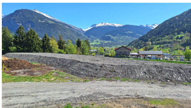
Stockage des terres en andains
