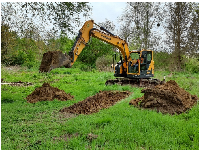
Figure 11. Fosse réalisée à la minipelle (source : Soltis environnement).
