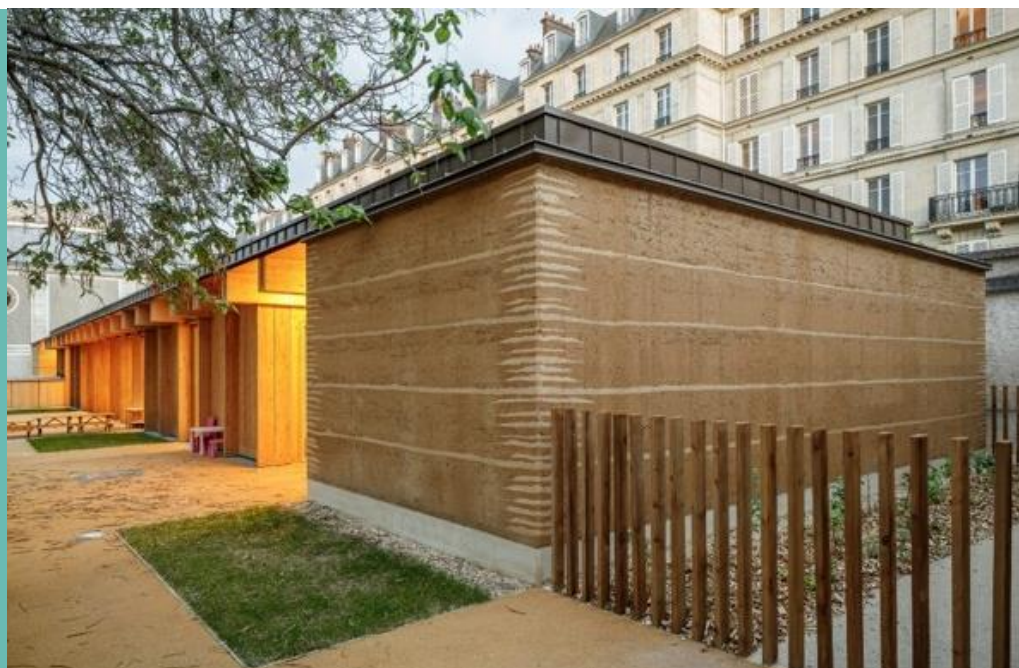
Crédit : Atelier Régis Roudil architectes, Crèche de l'Alma 2022
