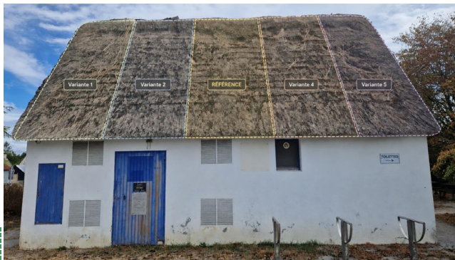
Photos annotées : implantations proposées. Bâtiment non chauffé et non isolé.
