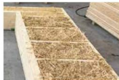
Murs à ossature bois isolés en paille
