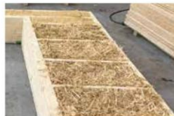
Murs à ossature bois isolés en paille
