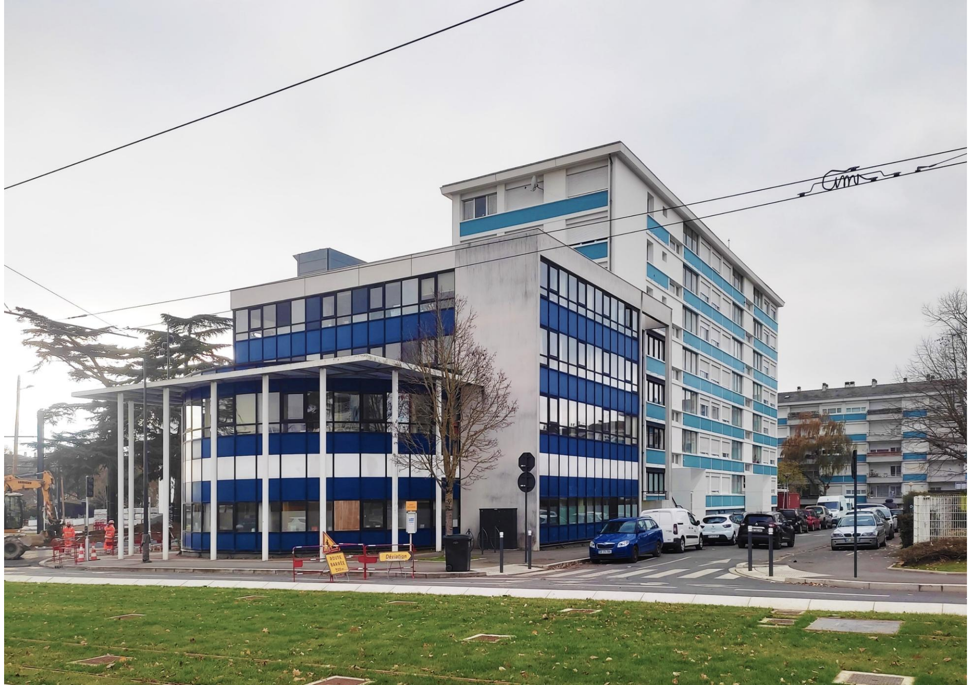
Le bâtiment existant
