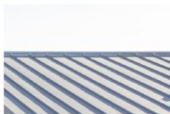
Couverture des préaux zinc à joints debouts Zinc teinte naturelle
