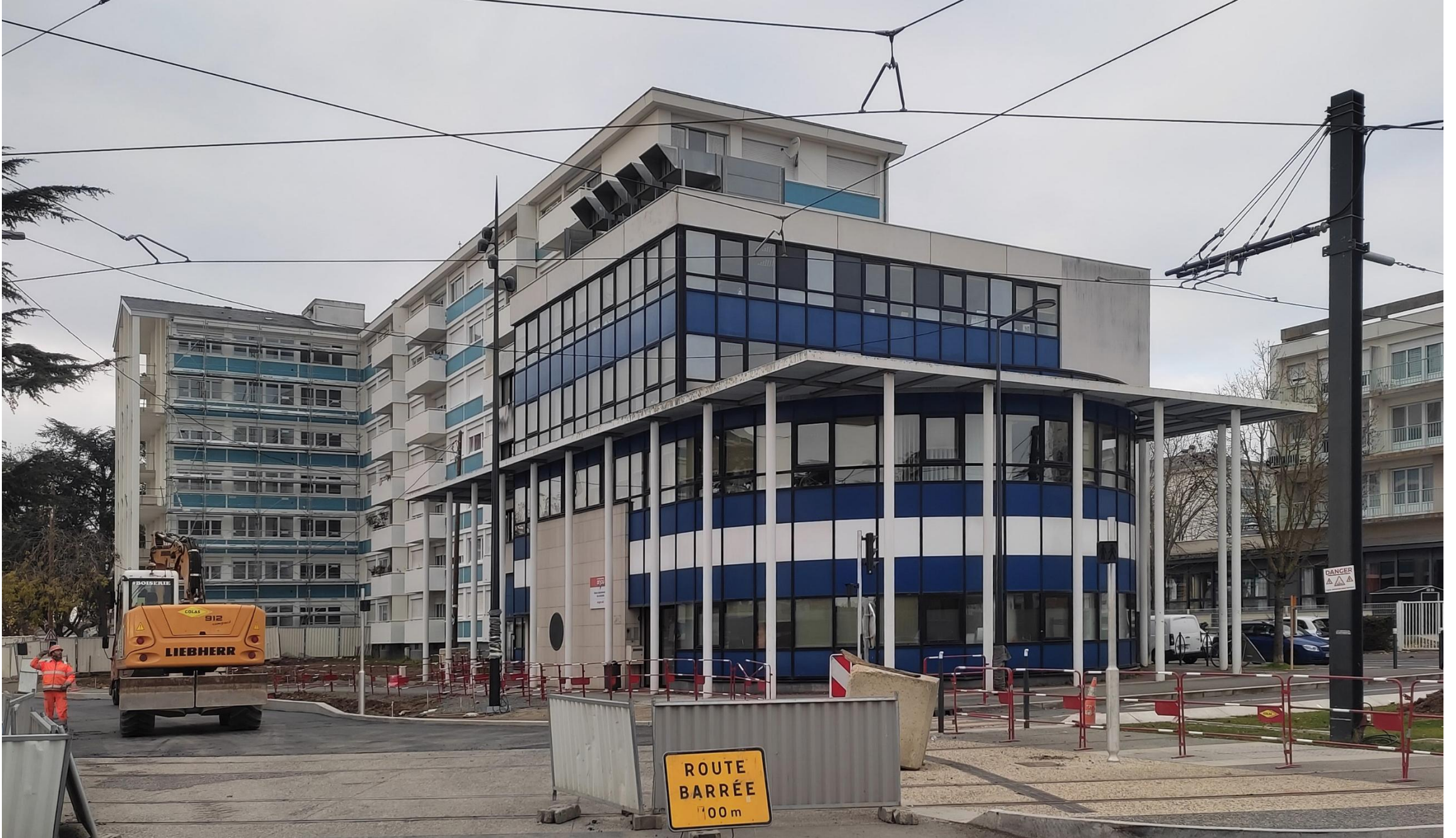
Le bâtiment existant
