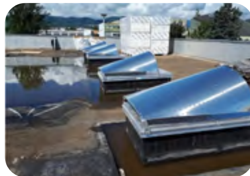
Crédit : Unilin - Rénovation des toitures-terrasses d'une résidence universitaire à Aubière
