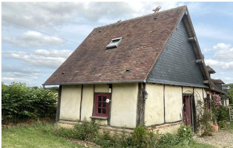
Figure 54 : Bâtiment démonstrateur à Puiseux-en-Bray dans l'Oise pour le test des solutions ITI terre chanvre et combijute
