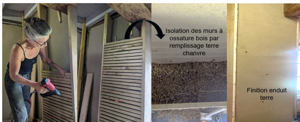
Figure 55 : Installation de l'ITI terre chanvre avec latte en bois et finition en enduit de terre
