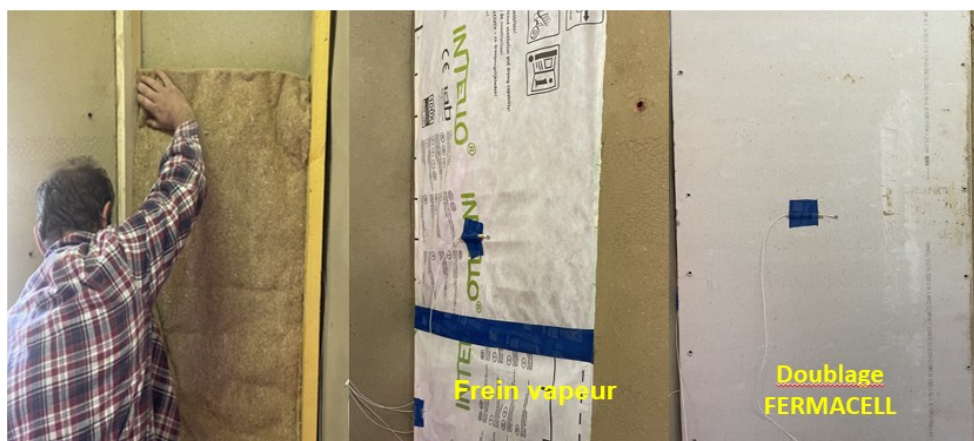
Figure 56 : Installation de l'ITI combijute avec frein vapeur et finition en fermacell
