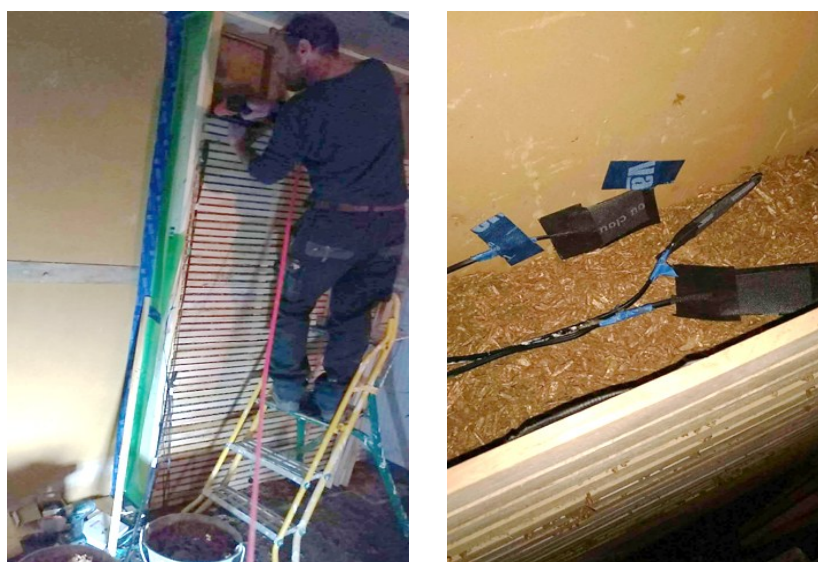
Figure 8 : Mise en œuvre de l'isolation terre/chanvre, avec l'ajout d'un lattage pour le support de l'enduit intérieur
