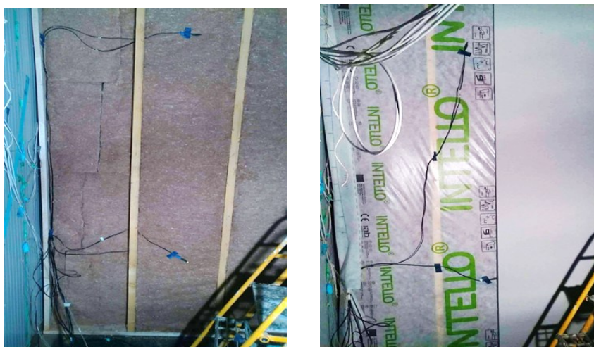
Figure 7 : Mise en œuvre de l'isolation en laine de jute, avec ajout du pare-vapeur Intello (ProClima) et de plaques de Fermacell
