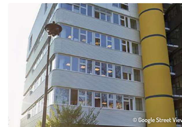
Rénovation Hôtel Industriel Serpollet, Paris
