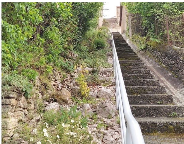
Passage André-Bon : installation de vivaces et arbustes avec paillage minéral en calcaire local.
