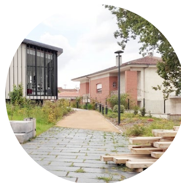
Dalles à joints enherbés aux abords de la médiathèque - Balma (31) MOE : Complément TERRE
