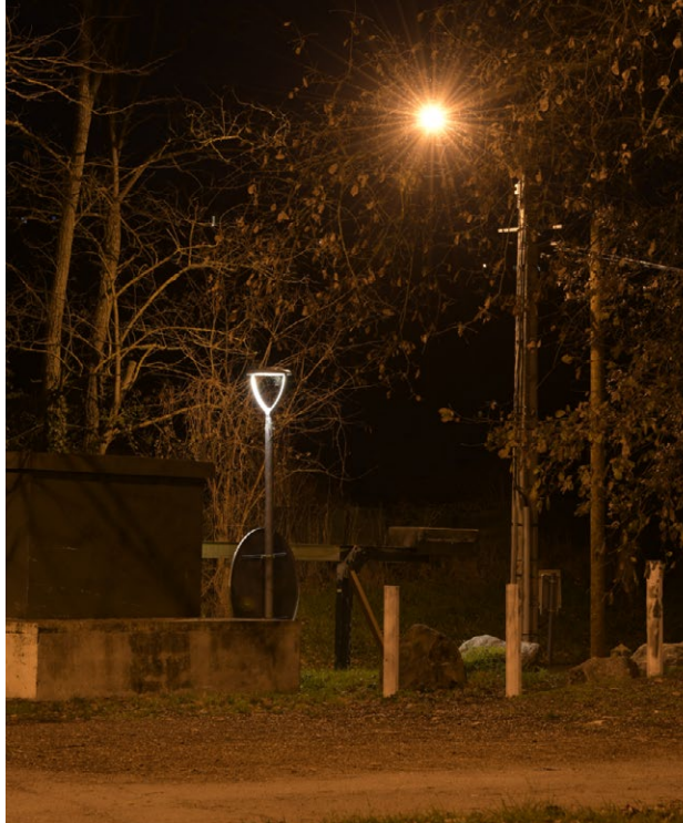
Parking de la RNR : l'éclairage LED n'a pas d'utilité. Le lampadaire SHP est trop puissant. Extrait du rapport Athena-Lum. © D. Loose - Athena-Lum/OEN
