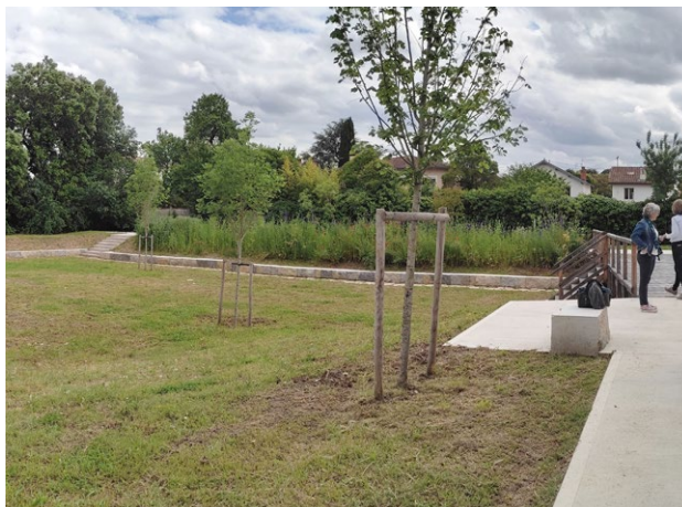
Espace public enherbé comme zone d'infiltration avec un système de surverse en cas de surcharge du bassin. Un lieu de sociabilité à la croisée des cheminements doux.
