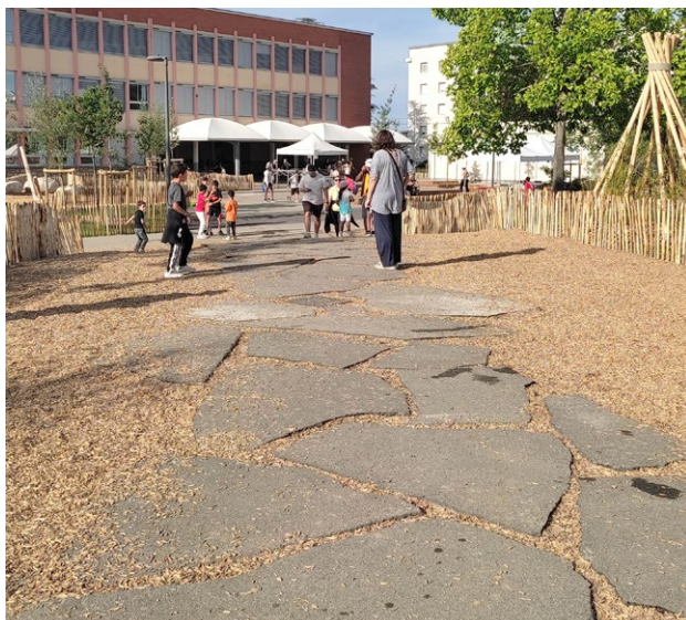
Réemploi des plaques d'enrobé décroûté repositionnées en pas japonais pour créer un grand axe de circulation. ©Lydie Lecarpentier
