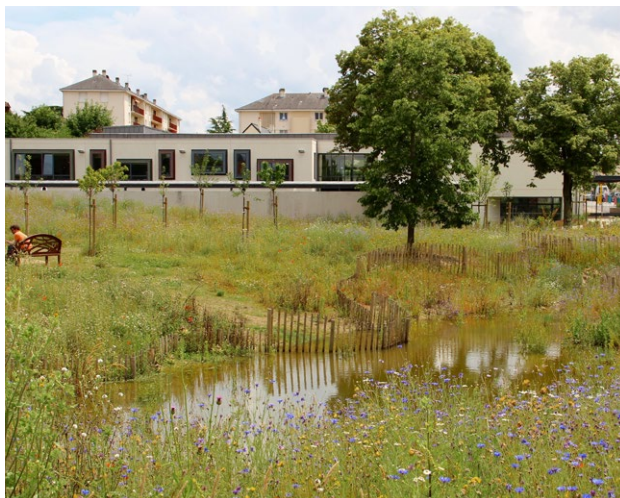
Mare écologique créée pour gérer les eaux pluviales du site et des abords, constituant une petite zone humide. © TALPA
