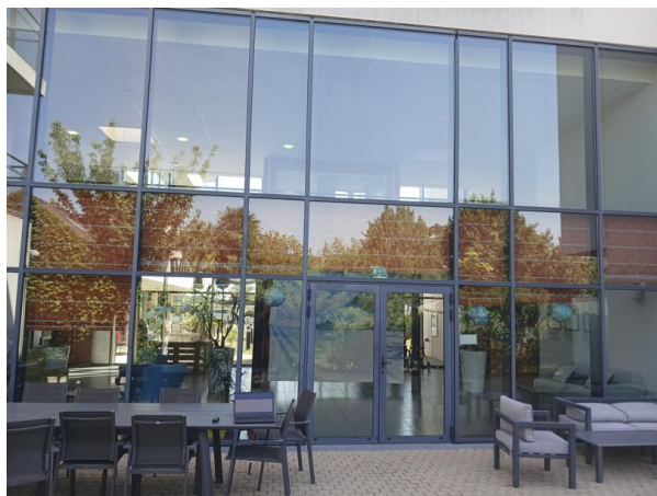
55 m 2 de verre plein sud au niveau de l'accueil (49)
