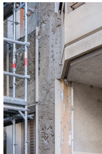
Application du corps d'enduit
