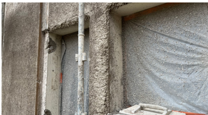
Application du corps d'enduit
