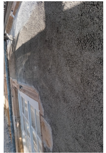
Application du corps d'enduit
