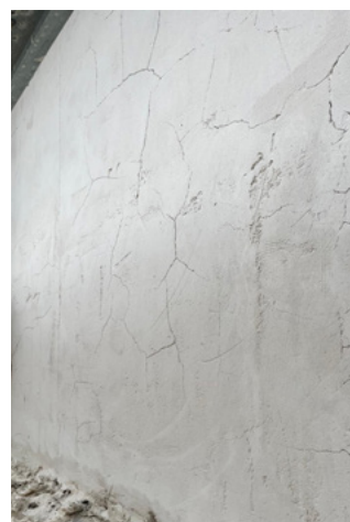
Enduit fissuré
