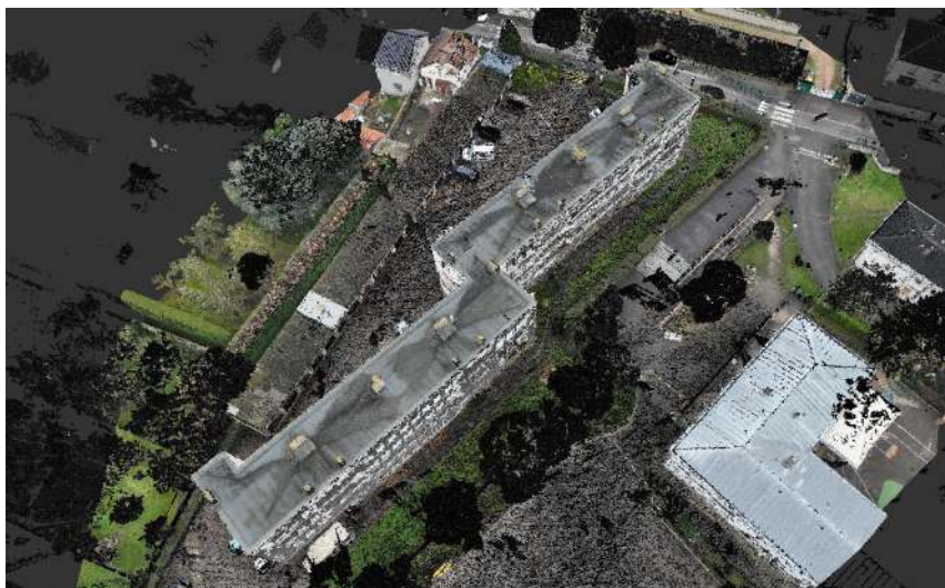
ITE - Rénovation énergétique Mantes la Jolie en cours
