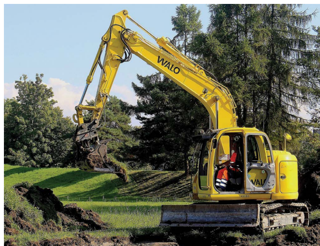
Figure 31 : Extraction frontale à la pelle © image libre de droit
