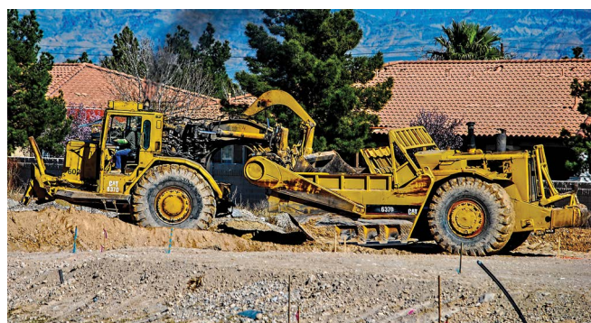
Figure 30 : Extraction en couches au motor-scraper © Tomás Del Coro, CC BY-SA
