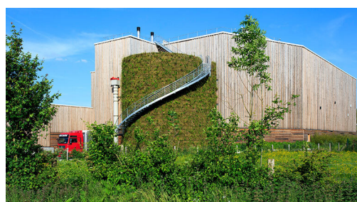
Pocheco : transformation d'un site
