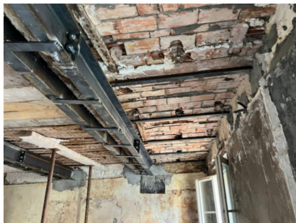
Reportage photographique du chantier - moisage de la charpente et du plancher R+5
