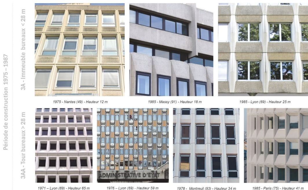
Figure 6. Exemples de façades de la typologie 3A « Structure béton et façade en béton préfabriqué », caractéristique de la période 1975-1989.
