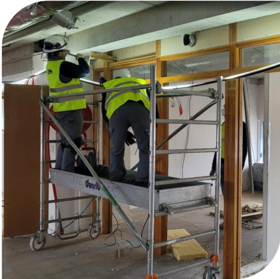
Dépose sélective et stockage
