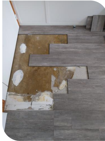
Test de dépose
