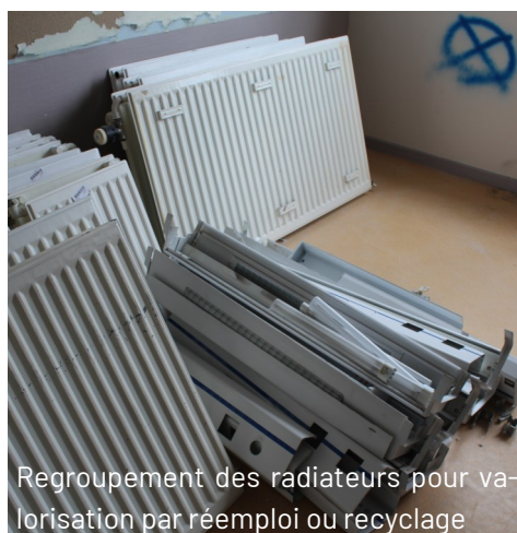
Regroupement des différents éléments par type au fur et à mesure de la déconstruction de la pièce
