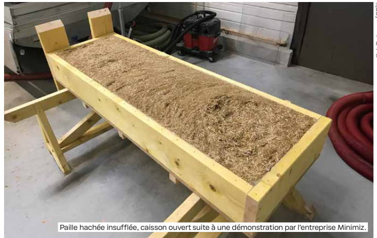
Insufflation de paille hachée pour la réhabilitation thermique du restaurant universitaire Champlain, CROUS de Poitiers.
