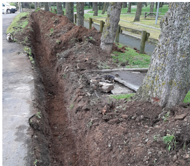
Ouverture de tranchée réalisée à proximité d'un alignement d'arbres de voirie, dans la zone de sensibilité racinaire. Chevelu racinaire impacté par le terrassement. / A. Guyot
