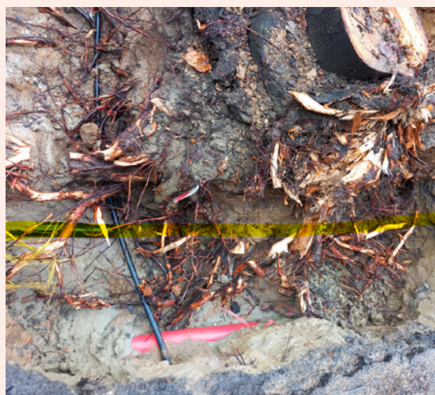
Racines enchevêtrées autour de la conduite en acier d'un réseau de gaz (surligné en jaune sur la photo) à Tourcoing, 2023. / GRDF
