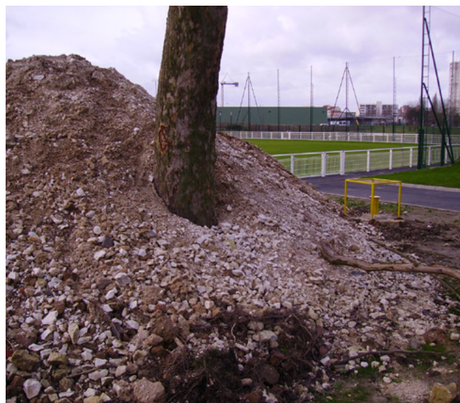
Dépôt de matériaux en pied d'arbre lors d'un chantier. / F. Freydet
