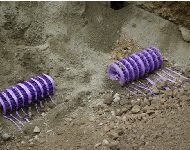
Grillage avertisseur violet, spécifique des réseaux de chaleur à Rennes. Pose lors du remblaiement de la tranchée en 2022, à 30 cm au dessus de la canalisation à signaler. / C. Courtant
