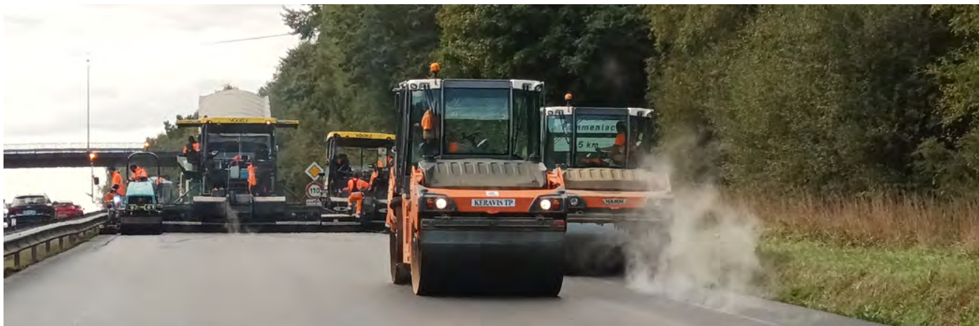
Travaux et pose d'enrobé sur route. / SCE
