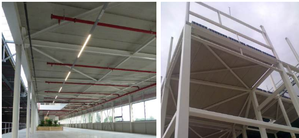
Fig. 4.17 Système de plancher démontable utilisant des éléments préfabriqués et un contreventement de plancher [29]
