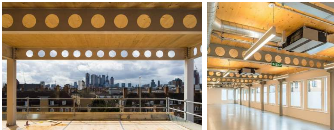
Fig. 4.18 Système de plancher démontable utilisant du bois lamellé-croisé (CLT) [36]
