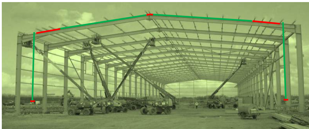
Fig. 4.2 Possibilités de réemploi dans les portiques : segments avec des modifications mineures
