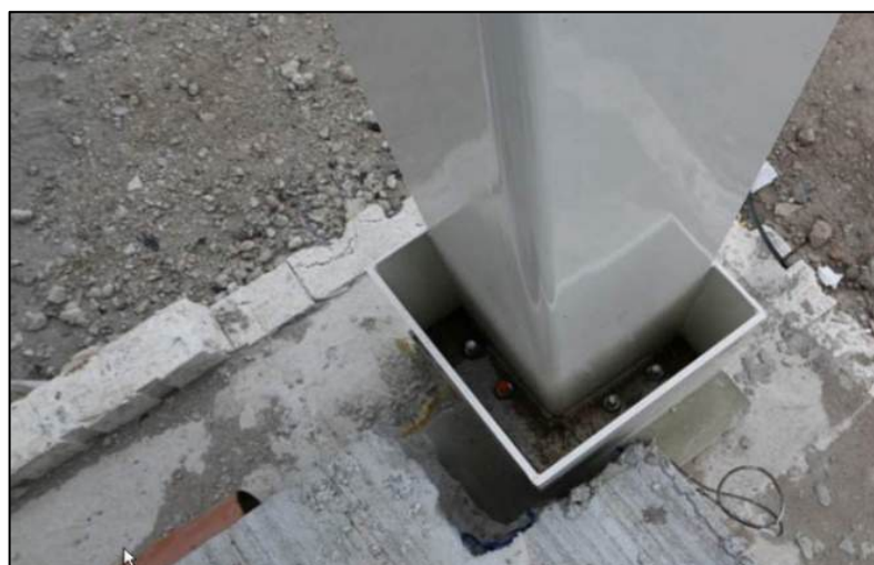
Fig. 4.9 Exemple d'assemblage de pieds de poteau accessible [30]
