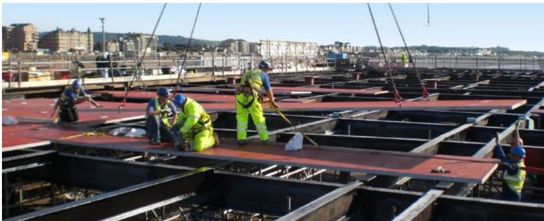
Fig. 4.19 Système de plancher démontable Panneaux SPS – deux tôles d’acier avec noyau en polymère [37]
