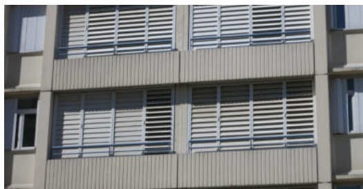
Brise-soleil type nacos sur un bâtiment des quartiers Pissevin à Nîmes, permettant de répondre à la saisonnalité et variabilité du vent et du soleil. © TRIBU
