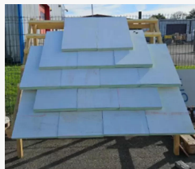
Couverture en pales d'éoliennes réemployées - La Paletière
