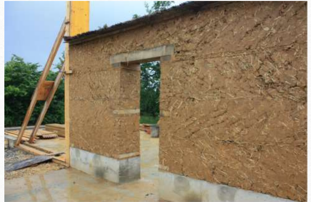
Construction en bauge © EIRL Terre Crue - Ghislain Maetz (35)
