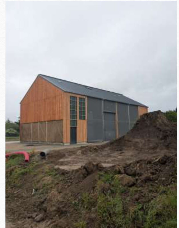
Fabrique terre LARONDE à GUERANDE (photo CREA Ecoconstruction)
