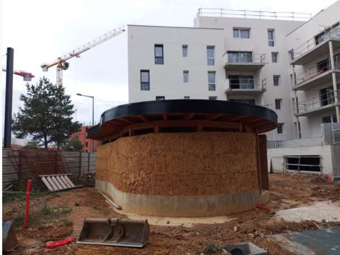
BAUGE locaux velos logements Empreinte à ANGERS (photo CREA Ecoconstruction)
