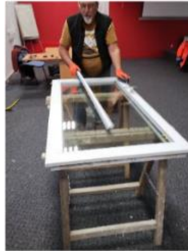
4. Séparation du cadre PVC et du vitrage
