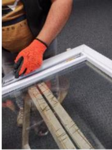
3. Coupe du joint + Déparclosage de la fenêtre
