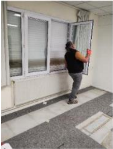
1. Dépose ouvrant
