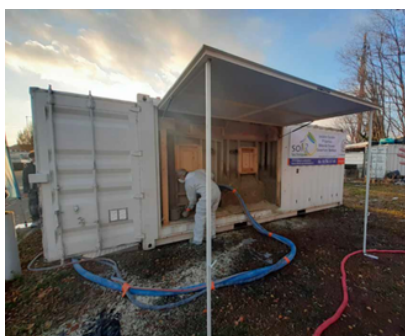
Container « Baraque à FIT » - Chanvribox du CD2E
