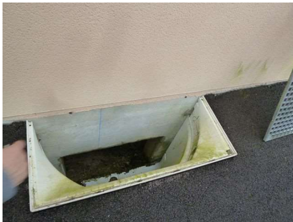
Trappe d'accès du vide-sanitaire
