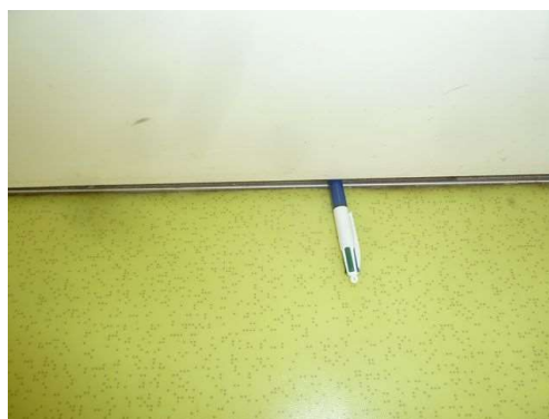
Exemple de détalonnage conforme
