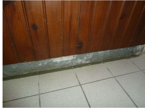
Etanchéification sur tout le linéaire du plancher bas de la classe des CE2/CM1
