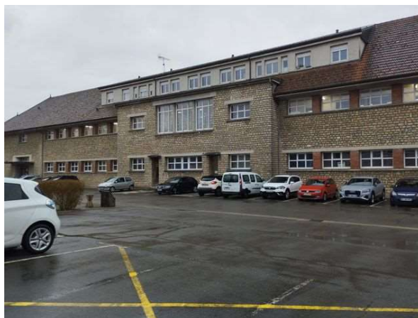
Vue extérieure de l'école primaire
