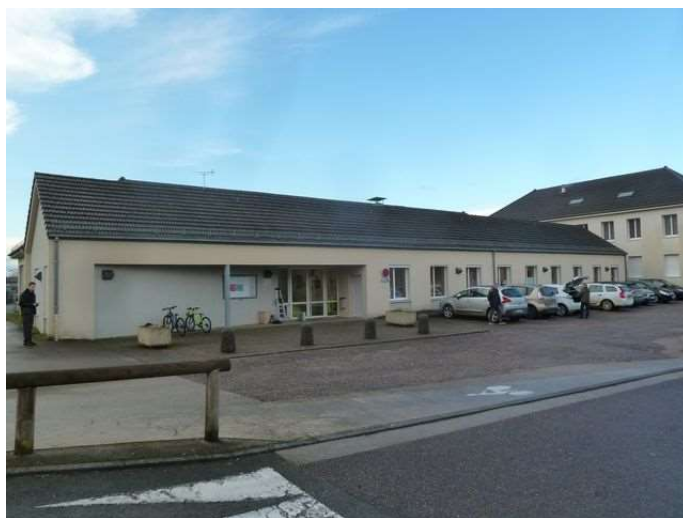
Vue extérieure de l'école primaire
