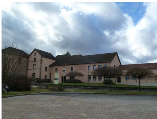
Vue extérieure de l'école primaire
