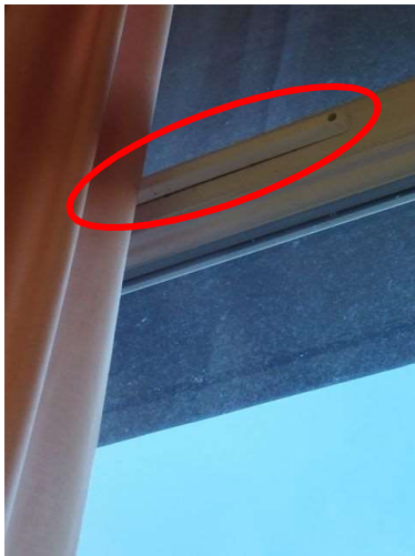
Exemple d'une entrée d'air sur une menuiserie
