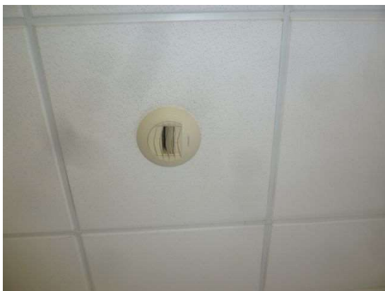
Exemple de bouche d'extraction sanitaire des élèves
