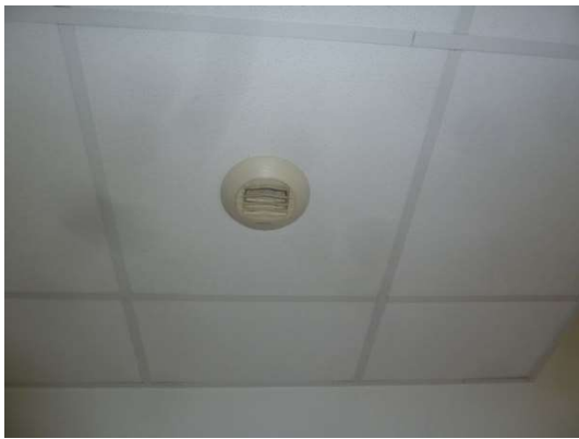
Exemple de bouche d'extraction sanitaire des élèves
