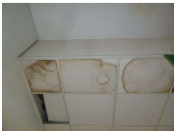
Vue du plancher haut du hall
