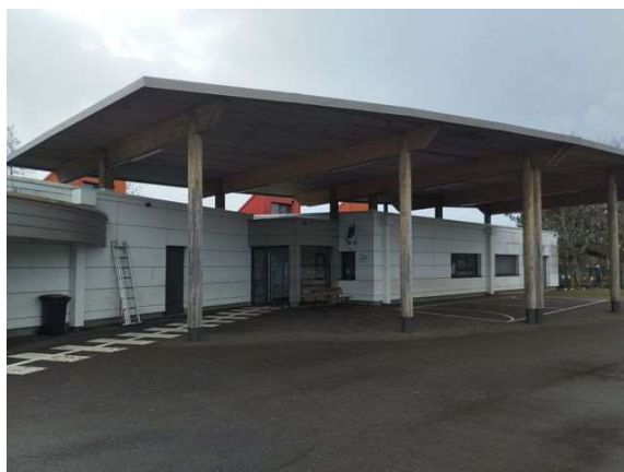
Vue extérieure de l'école primaire
