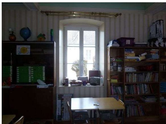
Exemple d'une menuiserie encombrée classe des CP au R+1
