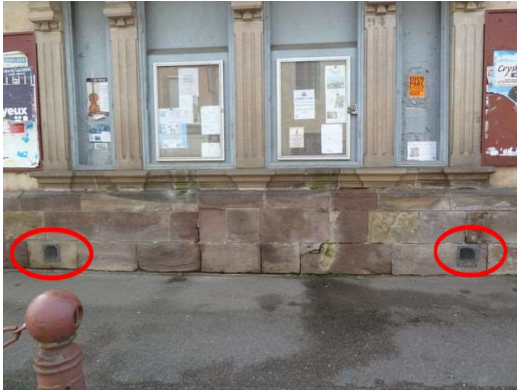
Vue depuis l'extérieur des carottages sous la dalle
