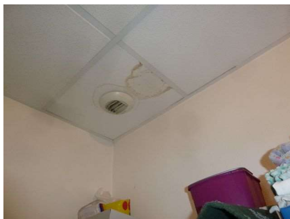
Bouche d'extraction encrassée
