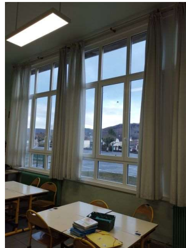
Exemple d'une menuiserie neuve sans entrée d'air
