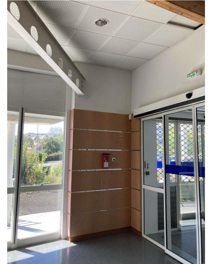
Des portes automatiques coulissantes
