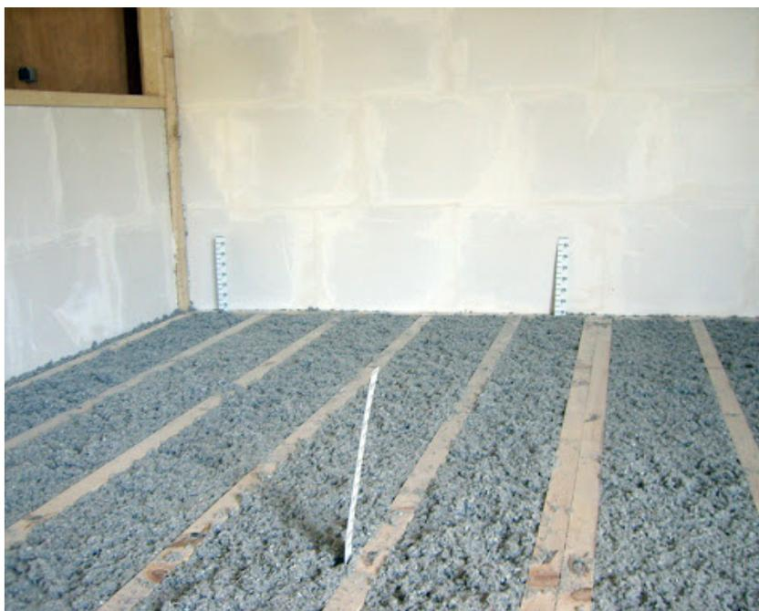
Soufflage de la ouate de cellulose dans les combles Source : [www.ouate.info](http://www.ouate.info)
