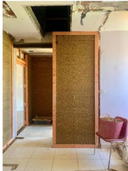
Cloisons séparatives des chambres réalisées en terre crue (terre allégée et enduit terre)
