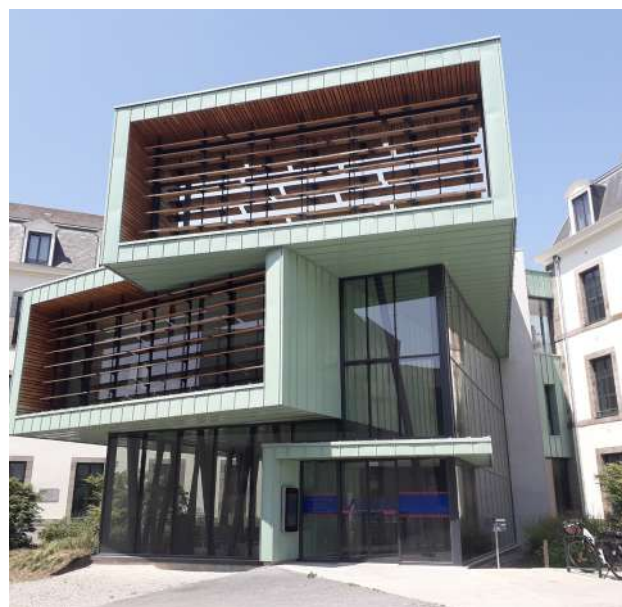
Figure 22 > Le Siège de la Laval Agglomération a investi le quartier Ferrié, où une architecture contemporaine en blocs s'insère dans le bâti patrimonial d'une ancienne caserne militaire : pas de doute, nous sommes dans un quartier DRAGON.
