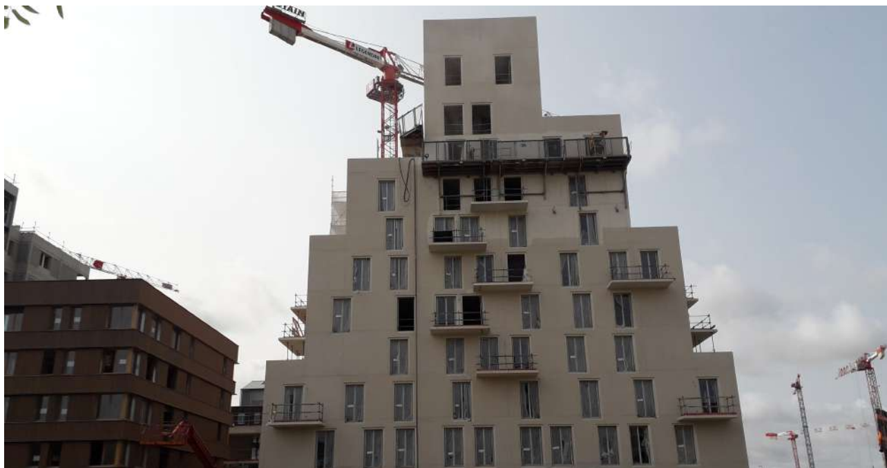
Figure 19 > Dans les quartiers SPHINX, on peut trouver des constructions hautes qui n'échapperont pas au regard curieux des passants, à l'instar de l'immeuble Allure qui se construit dans le nouveau quartier République sur l'île de Nantes.
