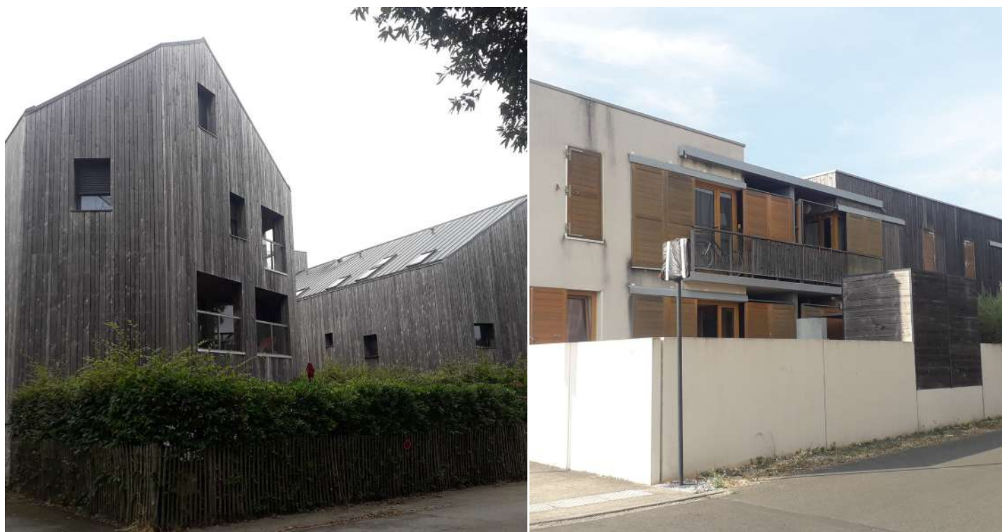
Figure 39 > Constructions en bois dans le quartier du Courtil-Brécard à Saint-Nazaire (à gauche) et architecture épurée dans le quartier des Montgorges à Poitiers (à droite).
