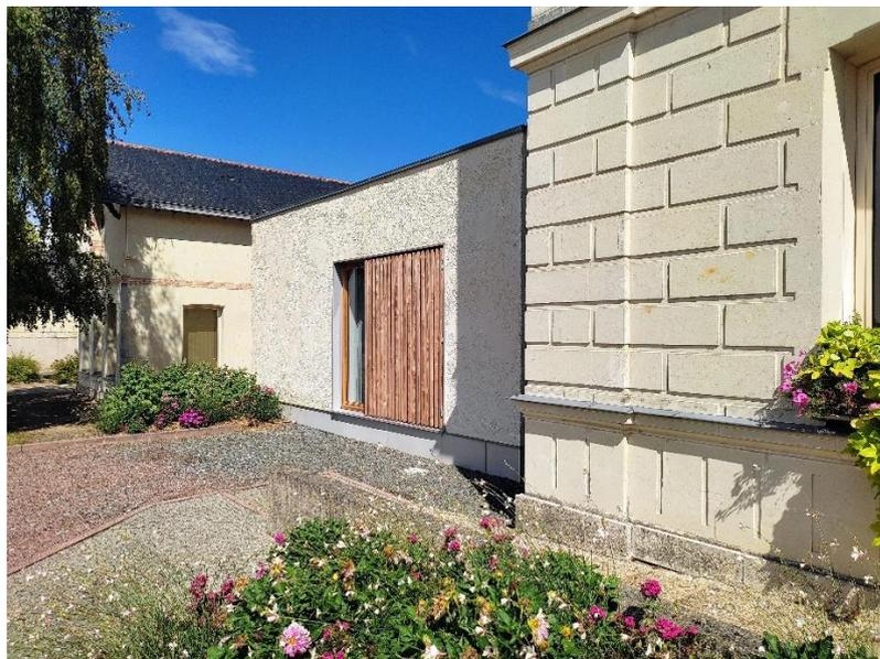
L'extension est construite en ossatures et charpente bois, isolées en bottes de paille et en laine de bois. Ce système constructif permet d'associer une isolation thermique renforcée à une forte inertie et à un déphasage thermique optimal. La perméabilité à la vapeur d'eau des murs en bois et paille enduite ainsi que l'évapotranspiration de la couverture végétalisée viennent renforcer le confort d'été à l'intérieur des locaux.
