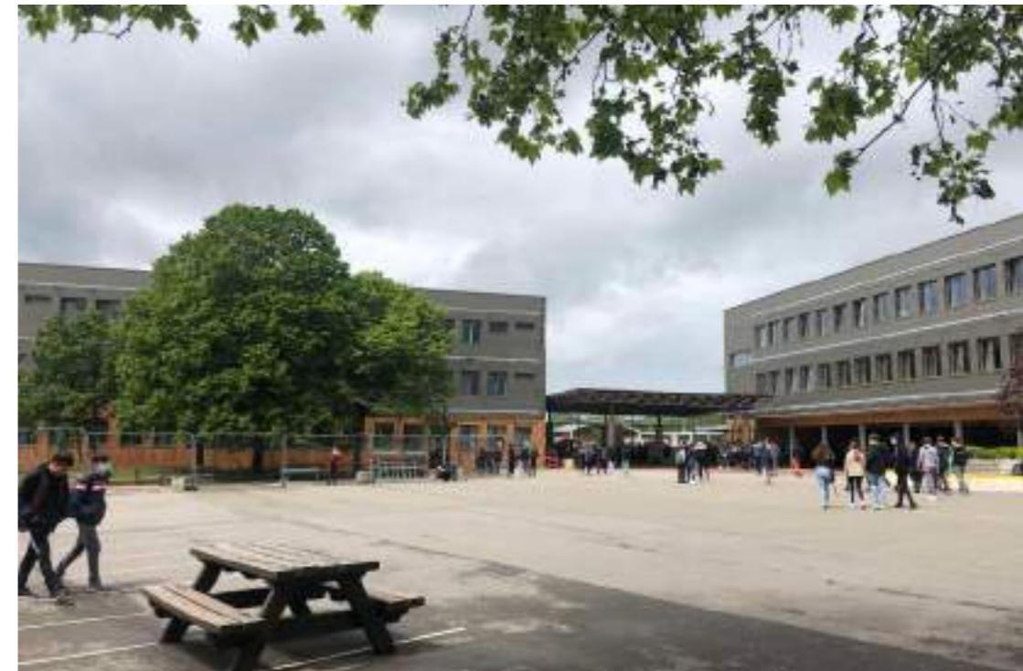
chantier en site occupé
