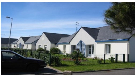
LA TURBALLE (44) Résidence Village retraite 10 logements
