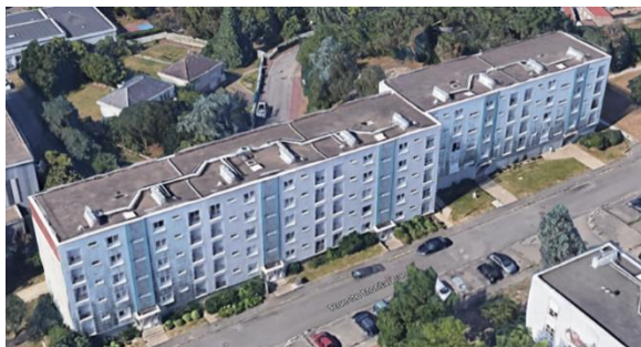
ST HERBLAIN (44) Résidence Moulin du Bois 46 logements
