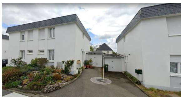
PLUVIGNER (56) Résidence La Croix Courte 30 logements
