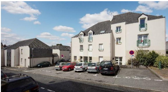
INDRE (44) 11 logements collectifs et 6 individuels
