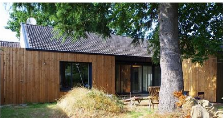
Maison individuelle à Carquefou
