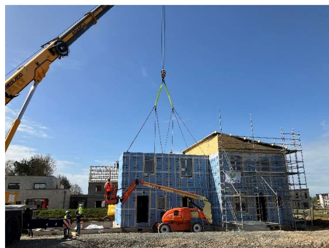
Pose d'un module 3D bois fabriqué hors site sur le chantier de MOOD au Rheu (35), le 28 mars 2023
