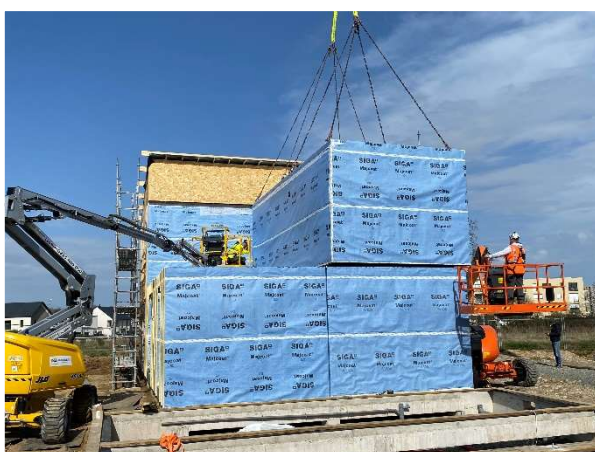
Pose d'un module 3D bois fabriqué hors site sur le chantier de MOOD au Rheu (35), le 28 mars 2023
