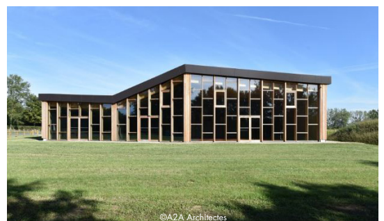
Maison des associations à énergie positive, Trangé
