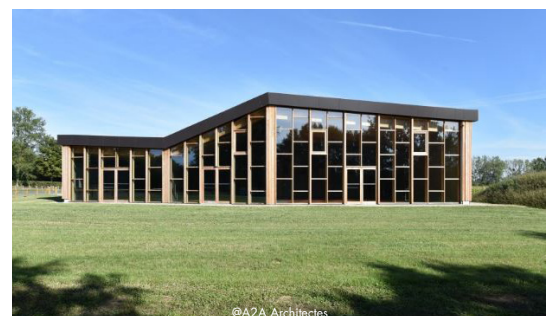
Maison des associations à énergie positive, Trangé
