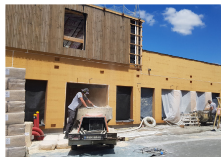
Visite du chantier des bureaux de la CAVAC, Moulleron-Le-Captif Matériaux à base de chanvre Architecte : CAN-ia
