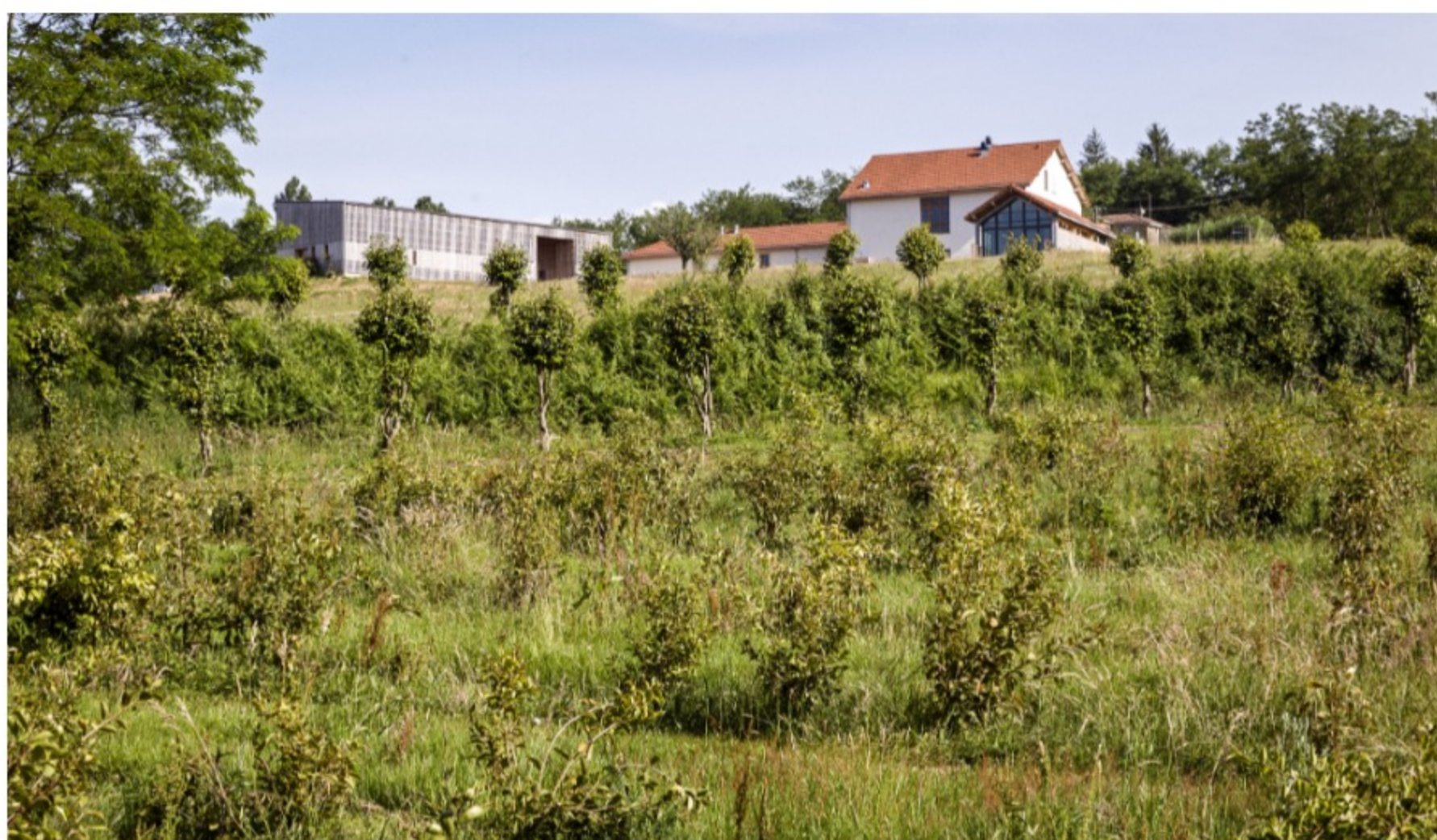
(© Pierre-Yves Brunaud / source : Cahiers du OFF 2021) Réhabilitation de la Ferme de Meyrin Gaujacq (Landes) - Architectes : (apm) & associés Paris
