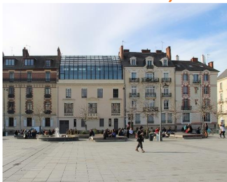
NORAC Surélévation Rennes (35)
